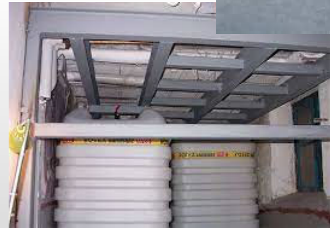
Variante 2 Tankanlage durch Verankerung sichern
